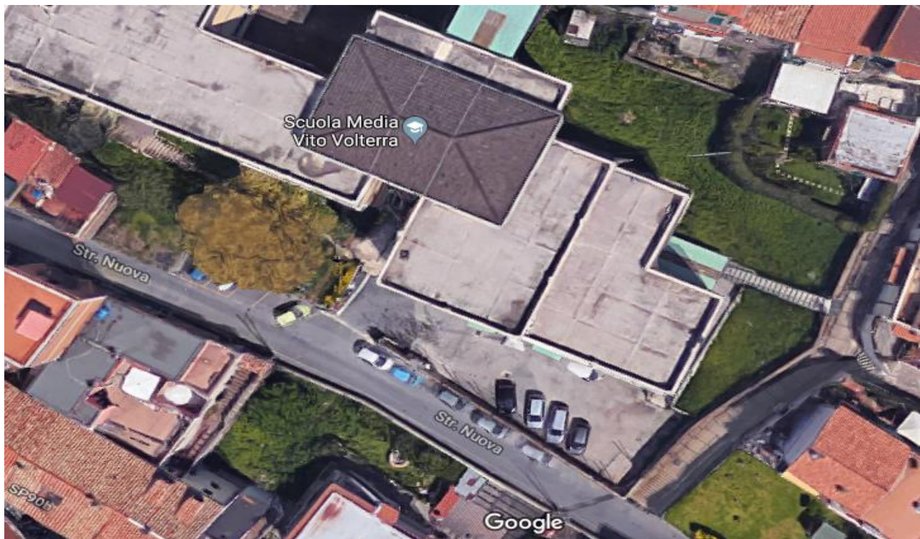
foto 1 – Istituto Comprensivo V. Volterra – Via Strada Nuova
